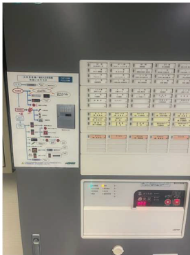
火災報知器の受信機 火災が検知されると、発報区域が点灯する。
