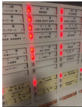
火災報知器の受信機 火災が検知されると、発報区域が点灯する。
