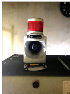
火炎センサーランプ アラーム検知されると点灯する。 とともにアラート音が出る
