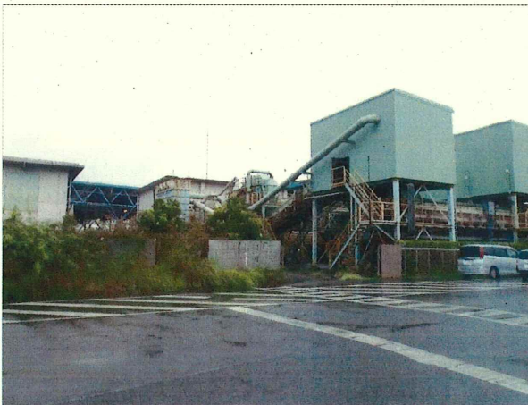
令和5年11月に火災が発生した 粗大ごみ処理施設の外観
