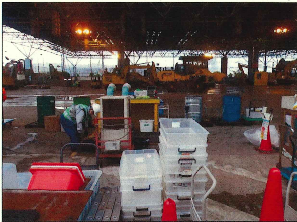
手作業で二次電池の取り外し を行っている。
