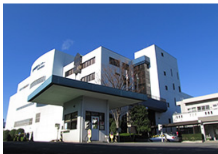
ごみ焼却施設・粗大ごみ処理施設
